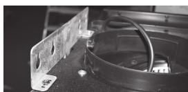
**2. Установка вытяжки.** Закрепите вытяжку на крепежной пластине при помощи креплений идущих в комплекте. Убедитесь что все крепежные элементы зафиксированы.
